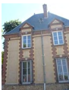
Bâti en brique
