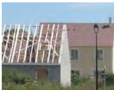
Parpaing en béton (nouveau lotissement)
