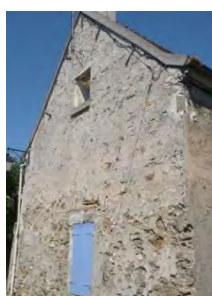
Bâti en pierre et crépi
