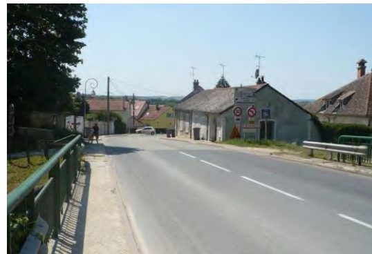
Traversée du canal de la Marne
