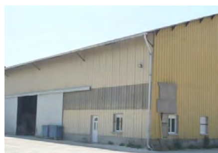
Tôle métallique (bâtiment industriel)
