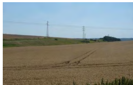
Pylônes électriques et Bois Garnier
